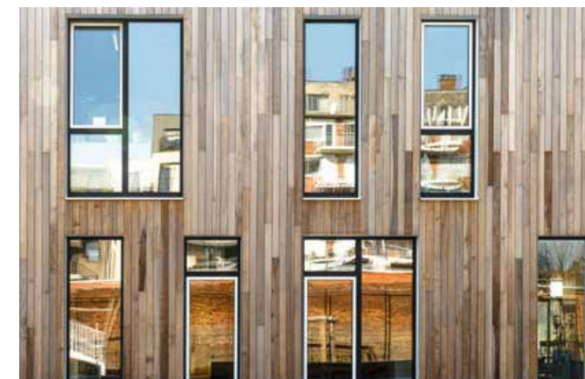
De architecten opteerden voor verticale houten planken als gevelbekleding.
